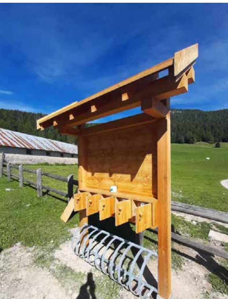
Colonnina per bici elettriche presso malga Arza
