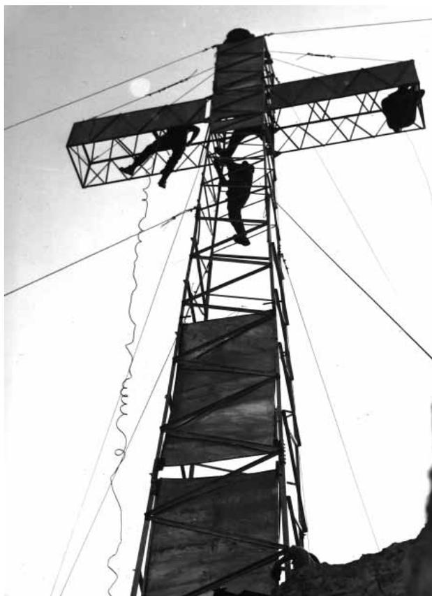
*Costruita nell'estate del 1959 era alta 13mt, interamente rivestita in lamiera era molto ben visibile dall'intera Val di Non. Il 21 gennaio 1960 una violenta bufera la distrusse parzialmente. Fu ricostruita priva di rivestimento per resistere meglio ai venti e ne fu ridotta l'altezza portandola agli attuali 9mt.*
