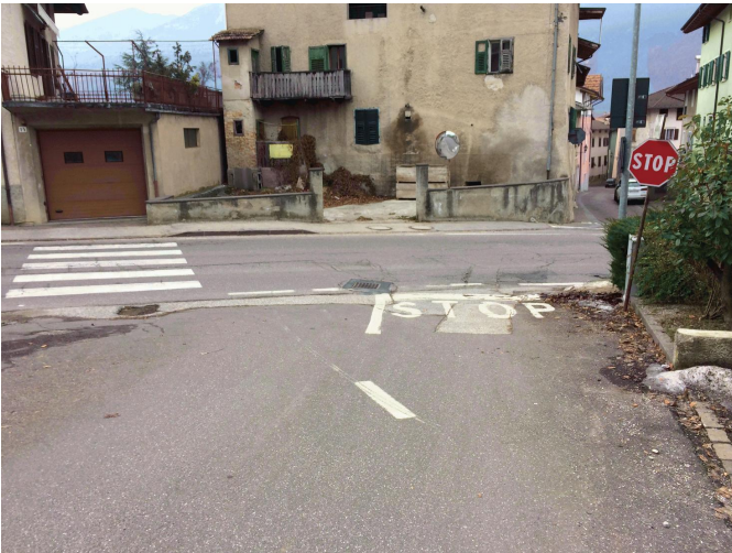
VISTA DA OVEST DELL'INCROCIO FRA LA S.P. 73 E LA VIA ALBANO
