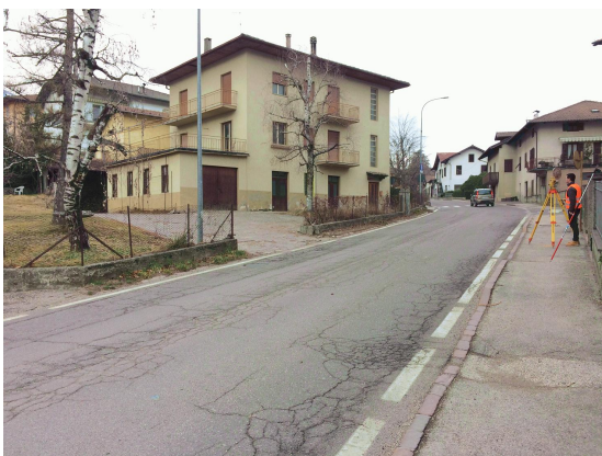
VISTA DA SUD EST DELLA ZONA INTERESSATA DAI LAVORI
