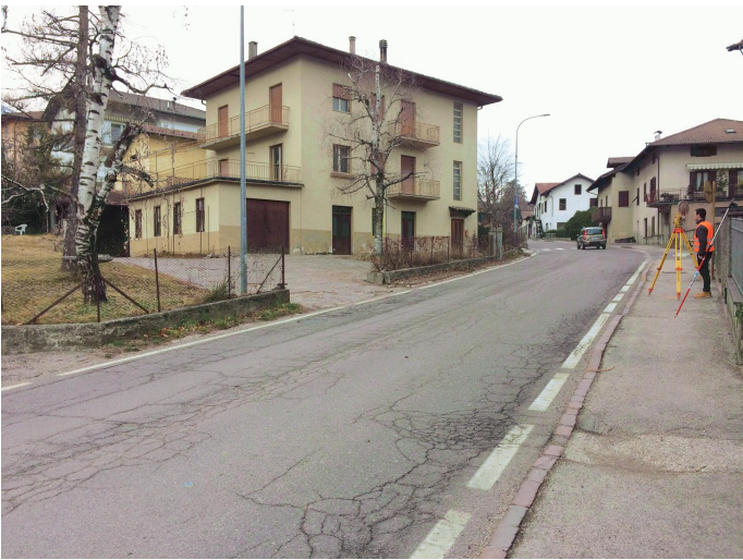
VISTA DA SUD EST, DELLA ZONA DI INTERVENTO
